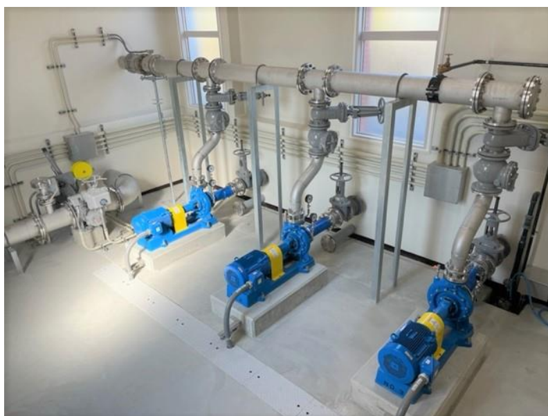
鹿ノ台配水場高区送水ポンプ更新（令和 4 年 6 月）
