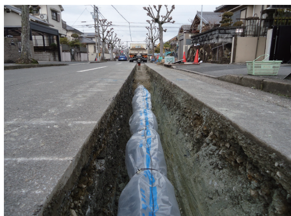
耐震管入れ替え工事
