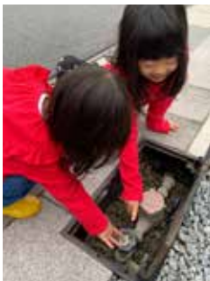
メーターボックス内の元栓を閉めて、漏水防止
