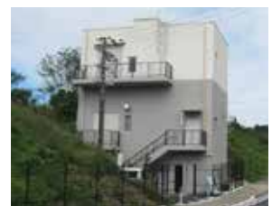
新設した新小瀬中継所
