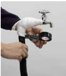
保温材などが取れないようしっかりと巻きます
