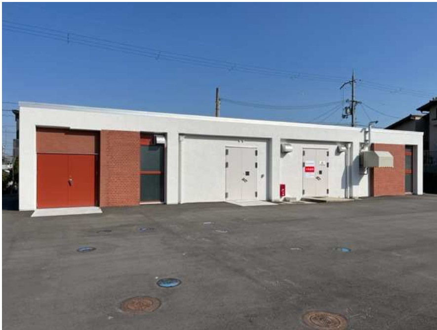
鹿ノ台配水場 ポンプ室電気室 耐震化 (令和4年6月)
