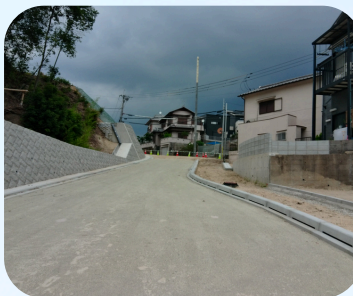
谷田小明線 工事現場
