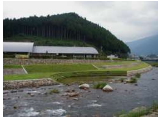
法面を分節化し、緑化を施した例
