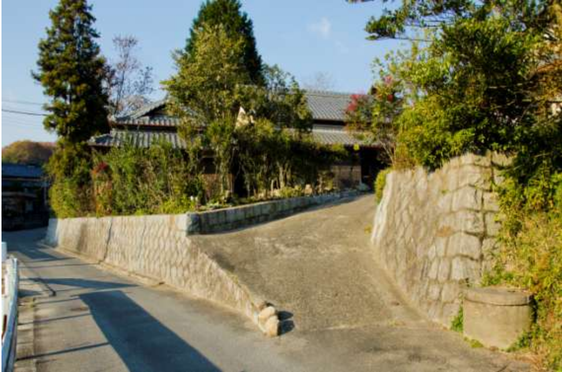
高低差を利用して「しきり」、通りと敷地は植栽でやわらかく「つなぐ」(高山町)
