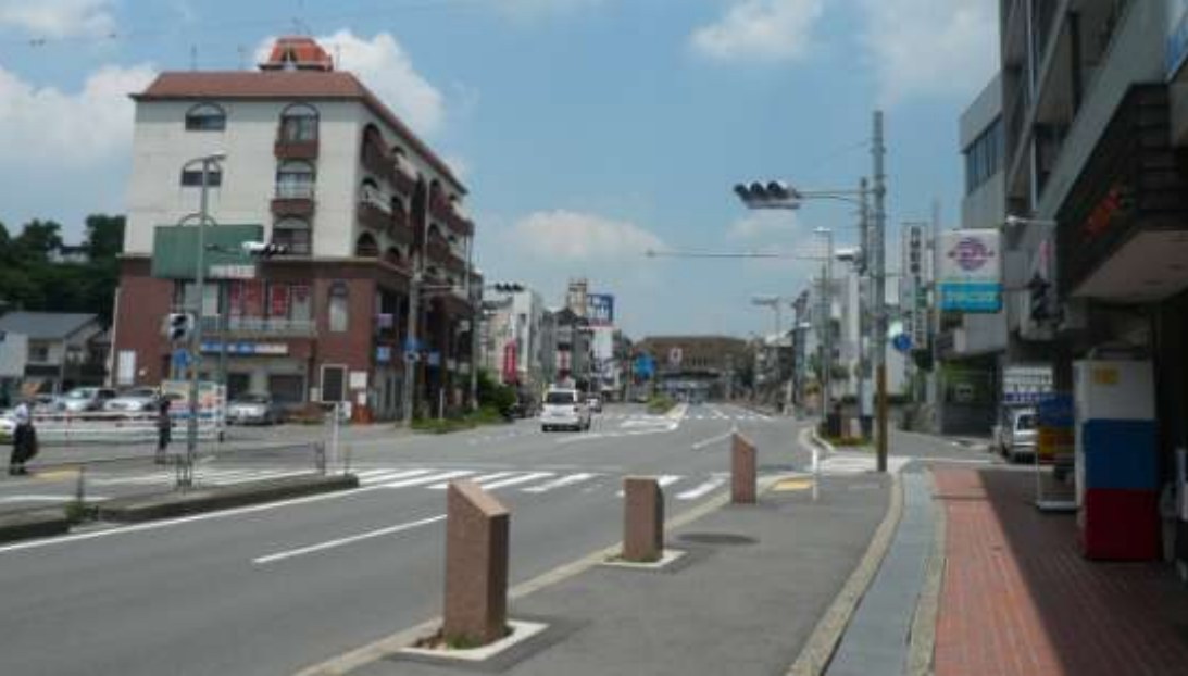
上 : 国道 168 号沿道 (東生駒駅付近) 左下 : 国道 168 号沿道 (一分駅付近) 右下 : 住宅地沿いの緑豊かな沿道 (白庭台)
