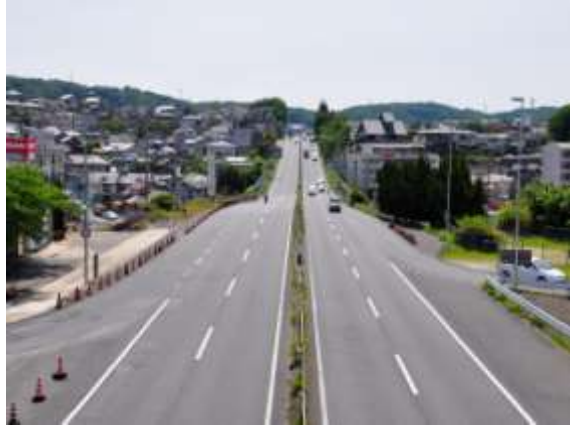
幹線道路の見通し（俵口町）
