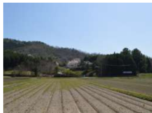
緑で遮へいした造成地
