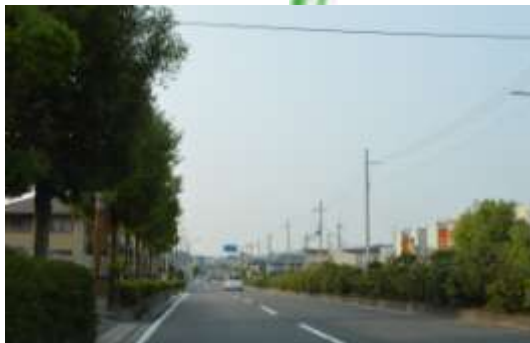
国道 168 号を見通す眺め（壱分町）
