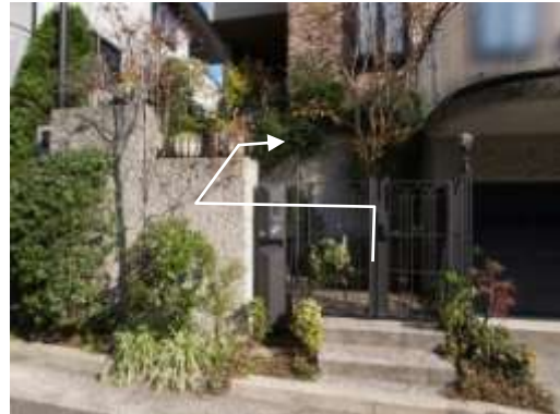
門扉と玄関の位置をずらして、植栽の スペースを生み出している
