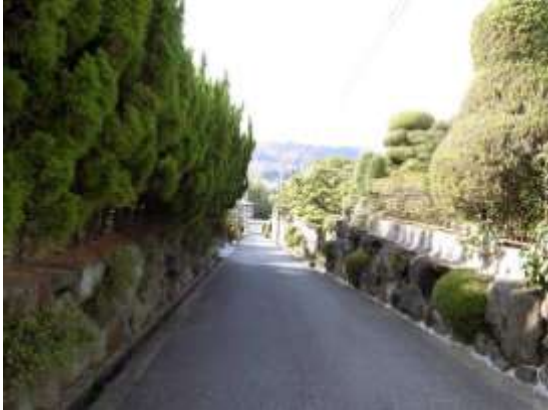
緑化により擁壁の圧迫感を軽減（生駒台）
