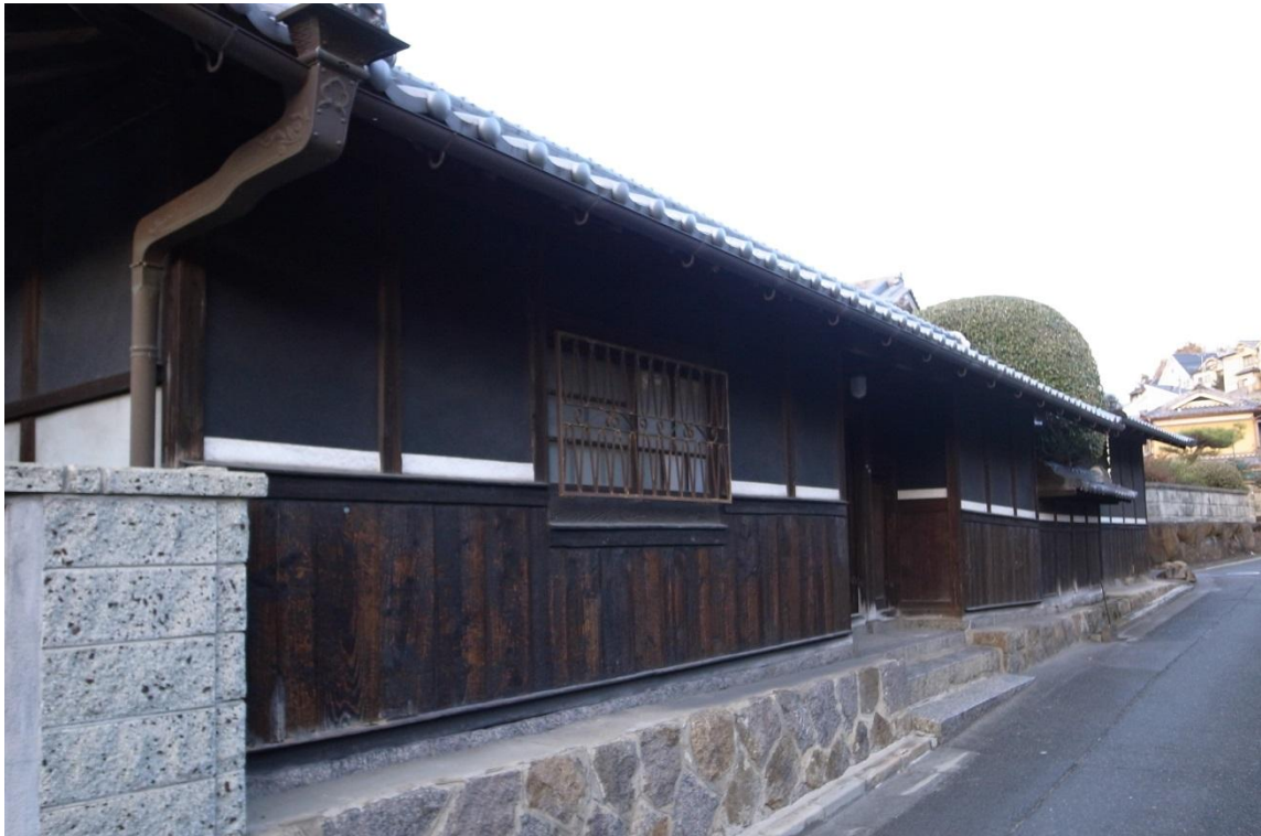
小さな石積みなどを使いながら斜面に沿って建てられた住宅（萩の台）
