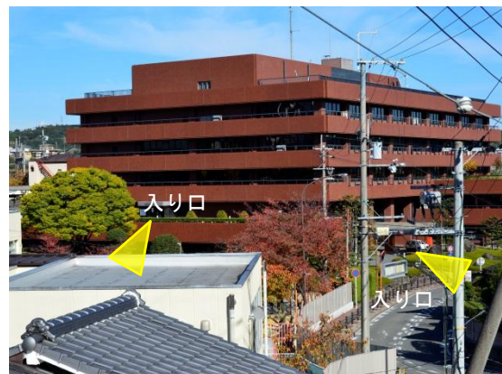
市役所は地形に沿って立地しており、出入口も1階、2階にある（東新町）
