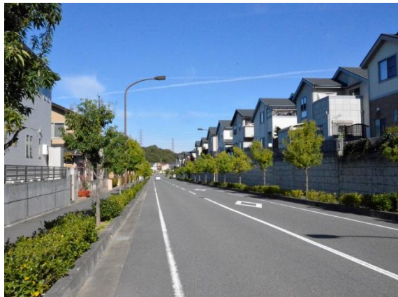
住宅地内の道路の見通し（西白庭台）
