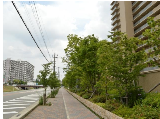
河川側に植栽を配置したマンション
