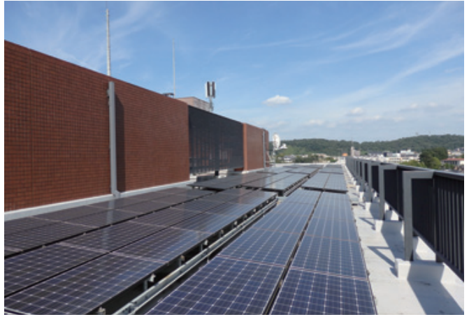
生駒市役所屋上の太陽光パネル
