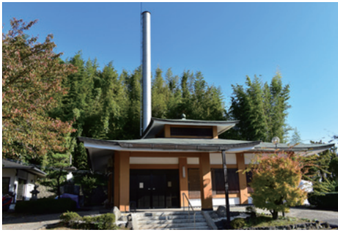
改修整備が予定される火葬場
