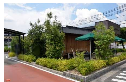
敷地内での緑化
