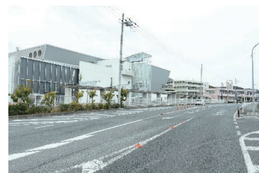
駅周辺公共施設（小瀬町）
