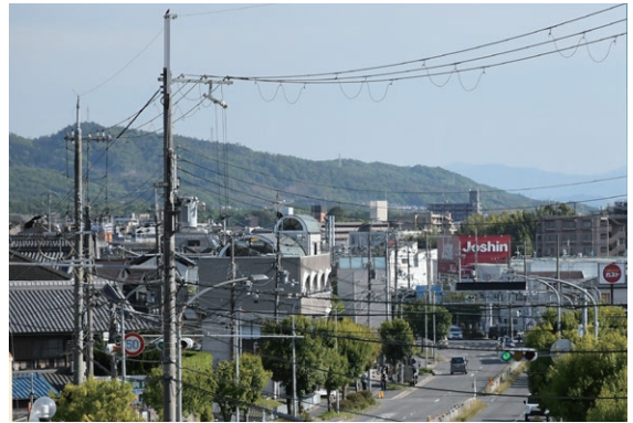
幹線道路沿道商業系施設 (小明町)
