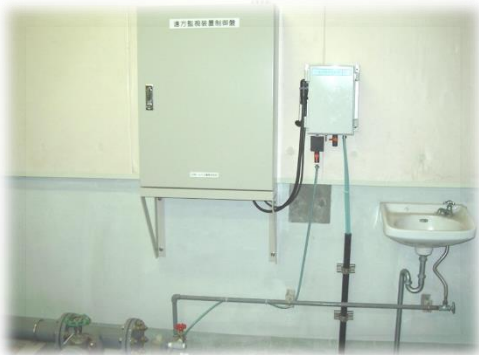
水質監視装置
