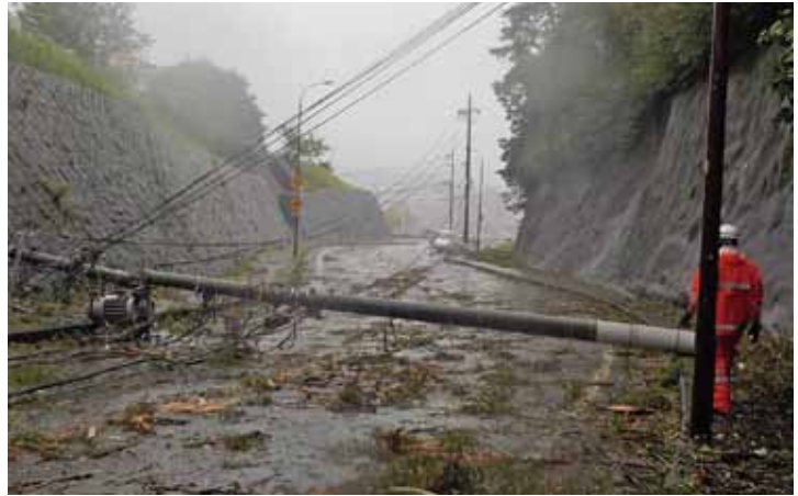
台風で倒壊した電柱
