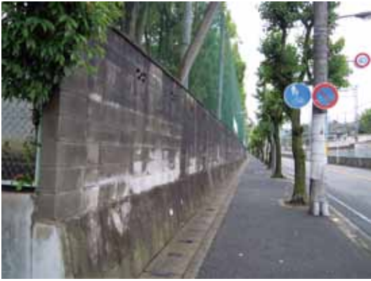
生駒小学校の北側にあるブロック塀
