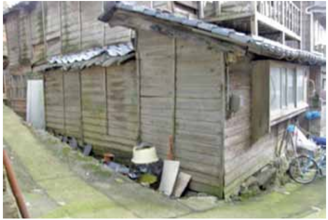
放置された空き家（国土交通省 HP）
