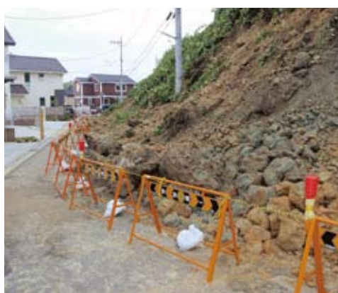
復旧が急がれる崩落現場
