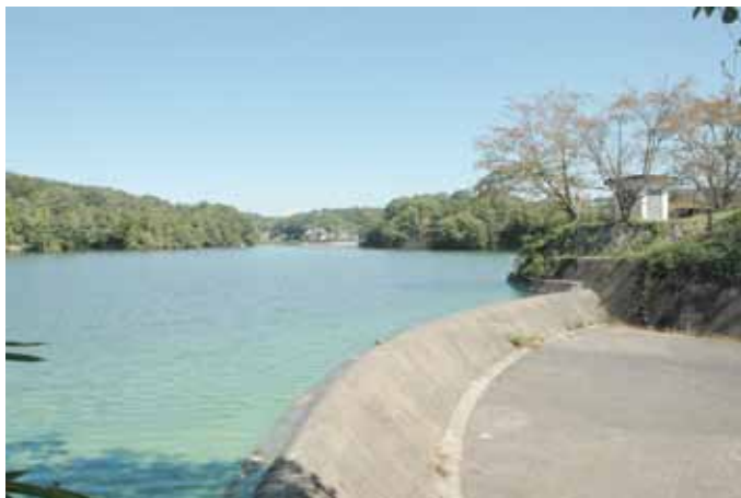
年次的に補修され 災害時の安全性が確保されている高山ため池
