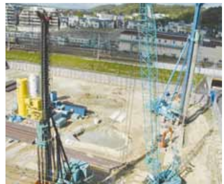
工事が始まった市立病院の建設現場
