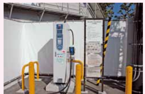
電気自動車用急速充電器 【市役所駐車場内】
