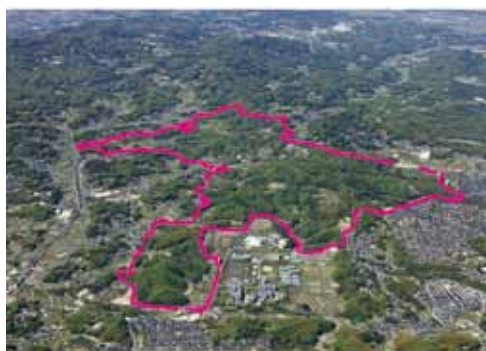
広大な土地が長期間の放置で荒廃が進んでいる【学研高山地区第2工区色線内】
