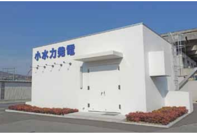
上水道事業を活用して発電することで、CO 2 削減を図る (山崎浄水場小水力発電)
