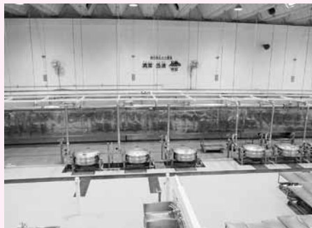
安全・安心な給食の再開にむけて改修が行われた学校給食センター
