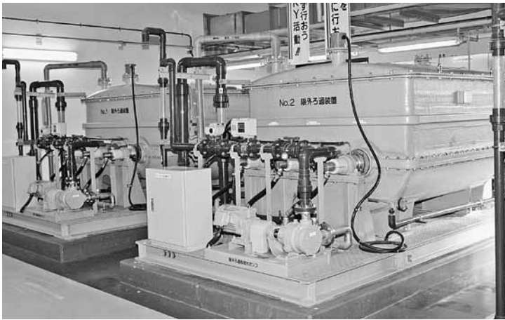
中長期的な利用の在り方を検討することとなった衛生処理場の機械設備
