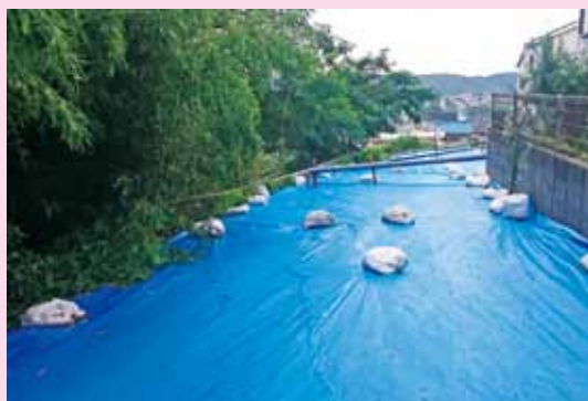
雨水の流入を防ぐため、ブルーシートで覆われた盛土
