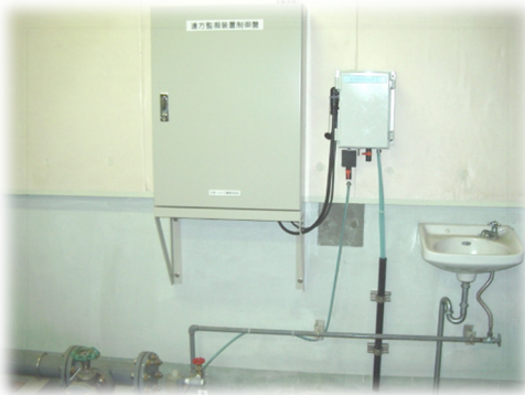
水質監視装置
