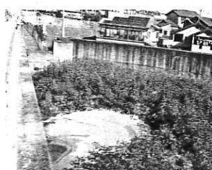
整備前の調整池
