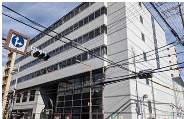
1階にイコマドが増設される生駒セイセイビル
