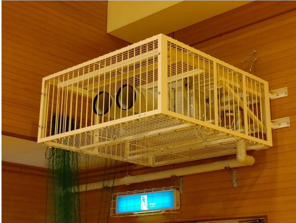
壁吊り型スポットクーラーを設置
