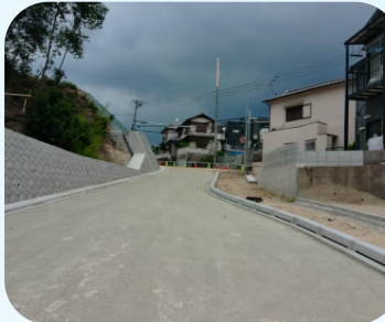
谷田小明線 工事現場
