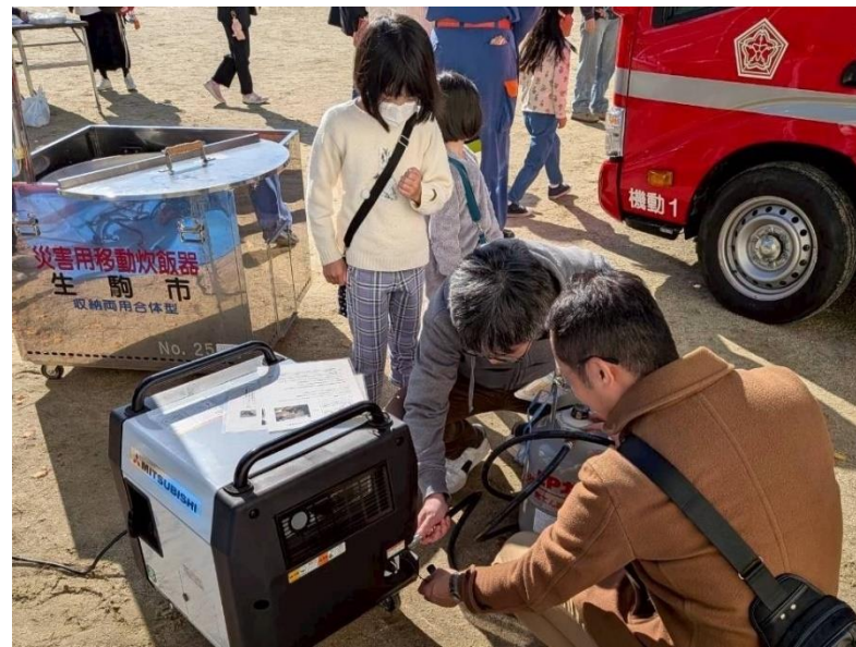
▲ 東地区（発電機操作訓練）
