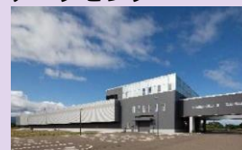
イメージ さくらインターネット石狩データセンター 出典：石狩市HP
