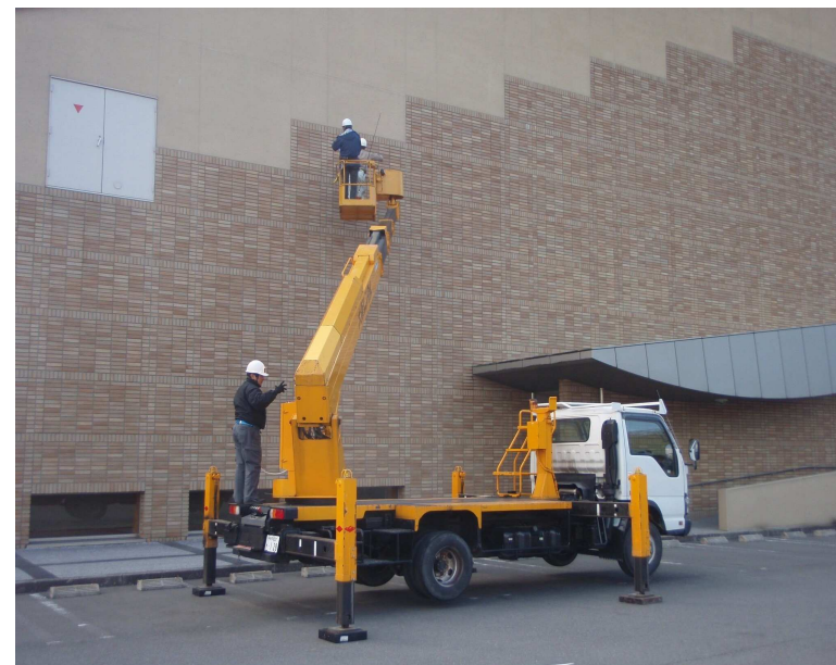
北コミュニティセンターの 外壁打診調査
