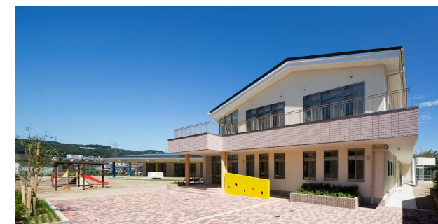
生駒台幼稚園改築工事 古い園舎を解体し新築
