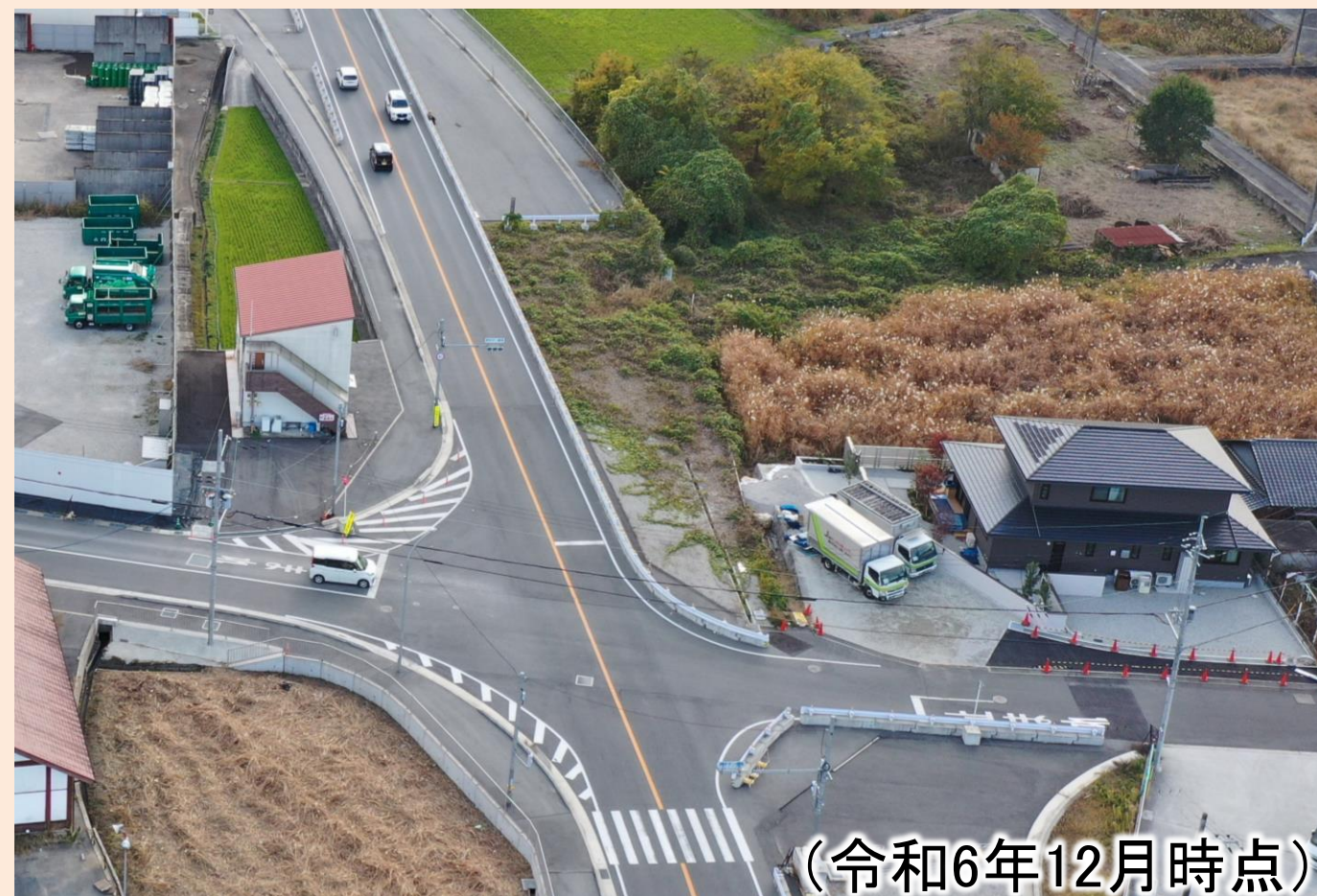
③道路擁壁工
