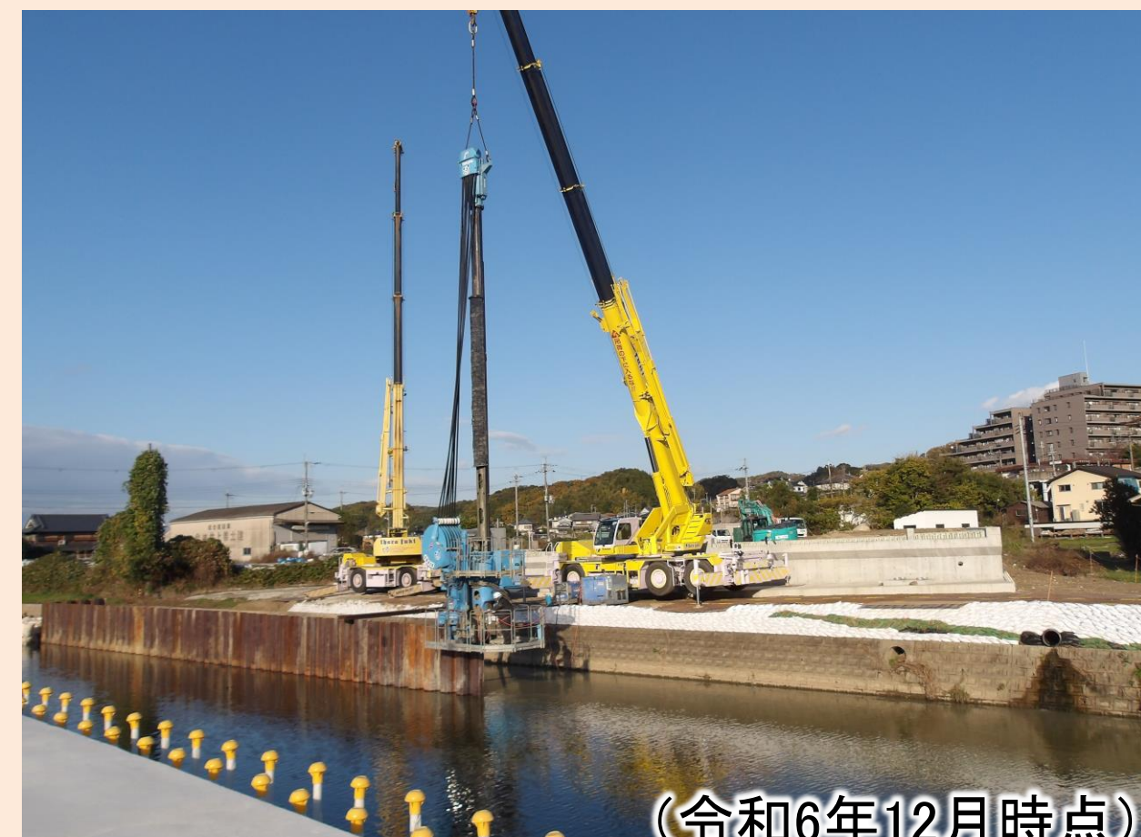
②(仮称)新小平尾橋 橋台護岸工
