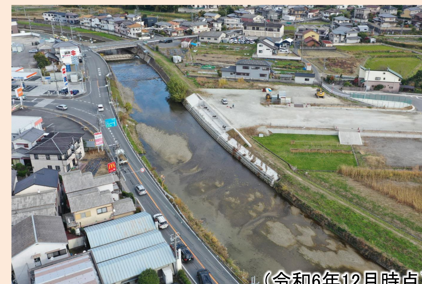
④(仮称)新乙田橋 橋台護岸工
