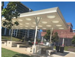
アートと融合した太陽光パネルのBBQ施設
