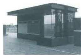
掲示板とシェルターを併設 した例
