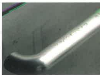
点字サイン（手すり）
