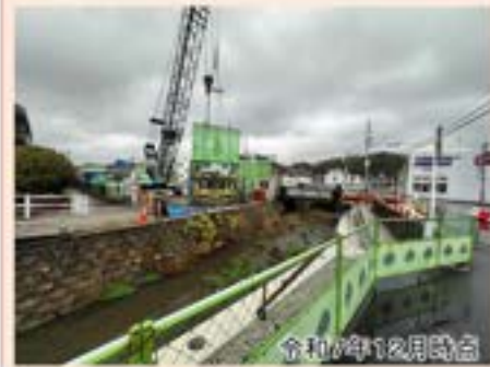
④ 新神田橋A2橋台工
