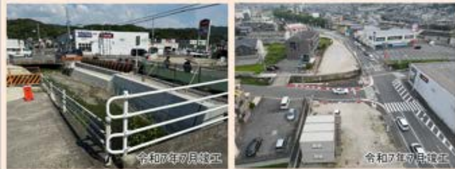
③ 新神田橋A1橋台工、市道迂回路設置工
