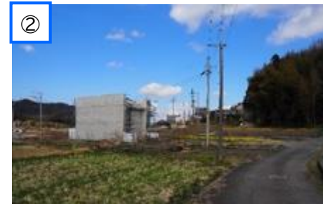
北田原跨道橋下部工（R7.3月撮影）
