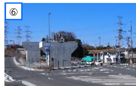
高山高架橋下部工（R7.3月撮影）
