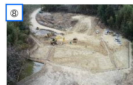
高山町土砂仮置場（R7.3月撮影）
