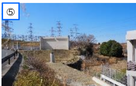
北田原線橋A2下部他工事（R7.3月撮影）
