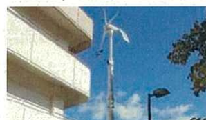
[小型風力発電機(鹿ノ台中学校)]
