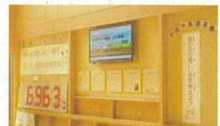
[エコパネルの設置]
