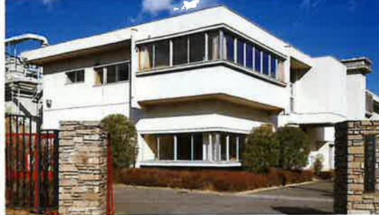
山田川浄化センター
