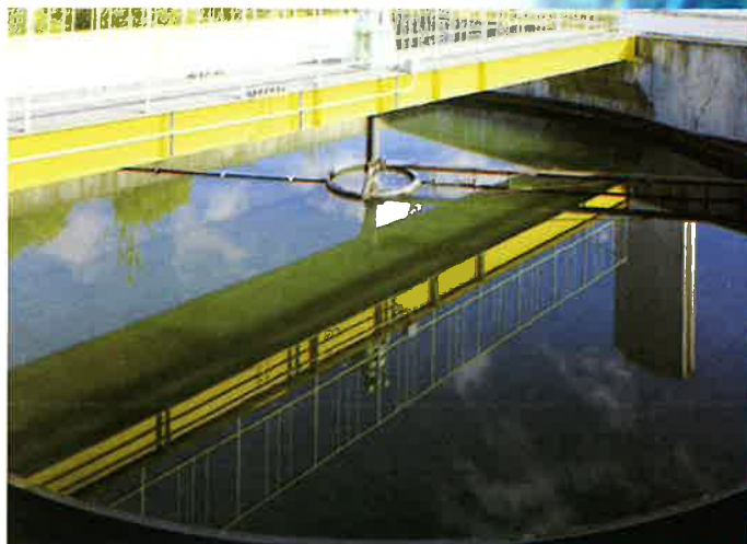
凝集沈でん池(山田川浄化センター)
