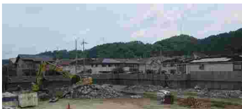
▲管理棟・保育棟上屋解体完了後
