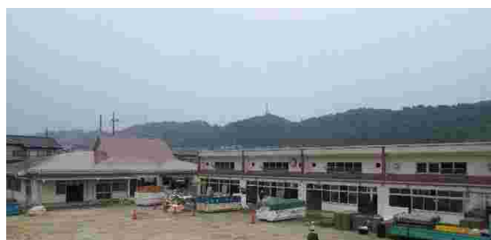
▲着工すぐ(渡り廊下などの除去)
