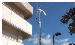
〔小型風力発電機(鹿ノ台中学校)〕
