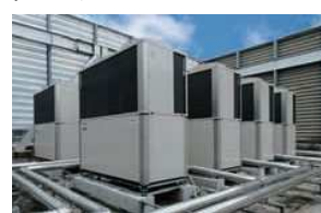
[電源自立型空調GHP] V 付加機能
