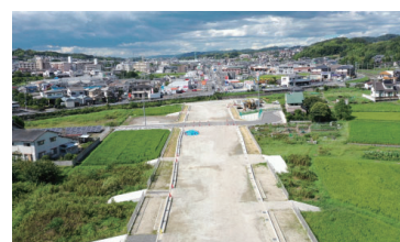
小瀬町付近(1工区)の状況
