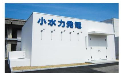
導入し、平成 25 年 3 月から稼働した。上水道の水流を利用した小水力発電では、全国で初めて固定価格買取制度(FIT)を利用し、発電した電力の全量を売電している。
