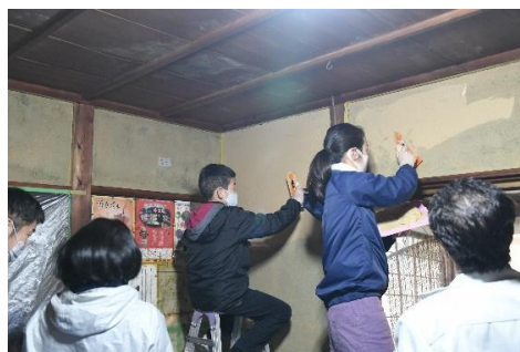
和室の壁を改修している様子
