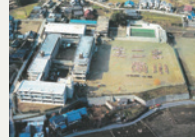
昭和54年頃の学校の全景
