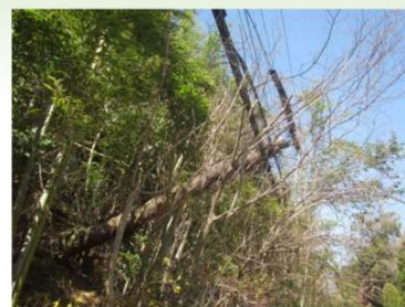
竹林内の広葉樹が枯れ、電線に接触
