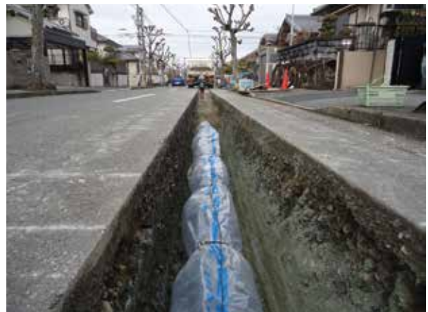
耐震管入れ替え工事
